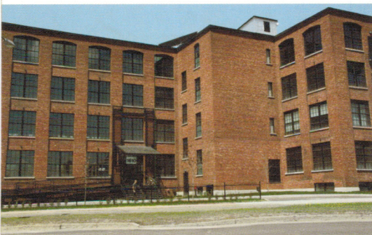
Sauf la toiture et la fenestration, l'enveloppe du bâtiment centenaire n'a pas été touchée.
