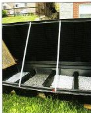
Derrière les panneaux noirs perforés, on retrouve du gravier servant de ballast et de capteur de chaleur. L'air est préchauffé par le soleil avant d'être tiré vers le bâtiment.
