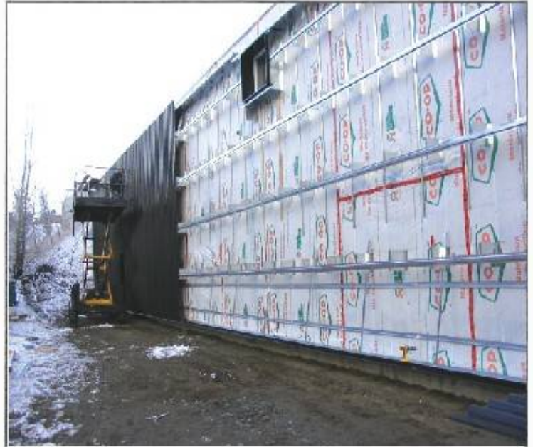
Les murs de l'usine Multi-X ont nécessité une construction particulière, pour économiser l'énergie tout en préservant l'environnement.
