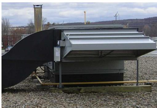
**Figure 19 :** Système modifié avec volet solaire latéral (à gauche) et le volet d'évitement (devant). Les deux moteurs avec couvercles protecteurs sont visibles de l'extérieur
