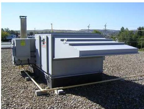
**Figure 18:** Unité de ventilation existante avec chauffage au gaz naturel avant l'installation du système
